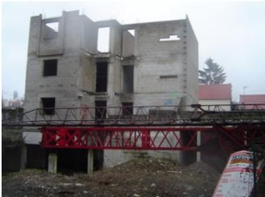
Quelle réalisation ce document cautionne-t-il ? Il s'agit d'une carcasse de béton de 3 étages et 12 m de haut pour une emprise au sol de 121 m<sup>2</sup>. En
